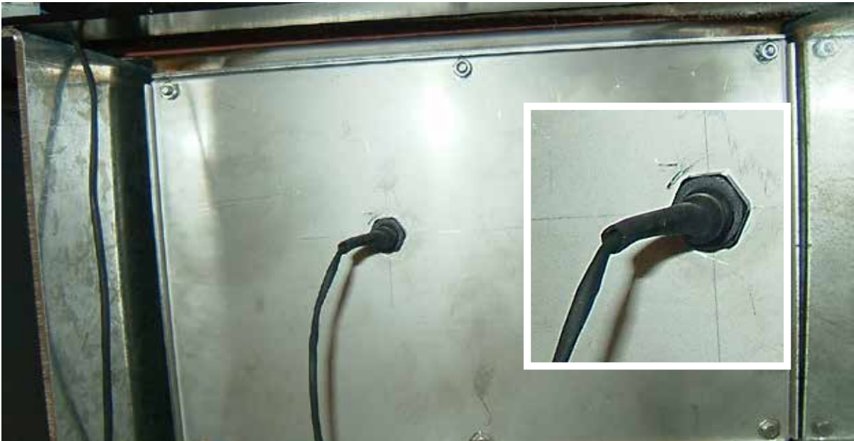
Положение датчика уровня конденсата
